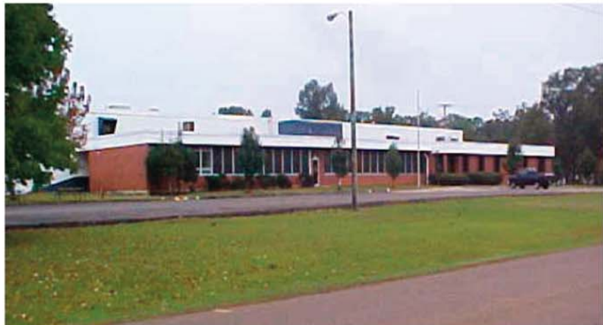
Instalaciones de Amory, Mississippi (Estados Unidos)
