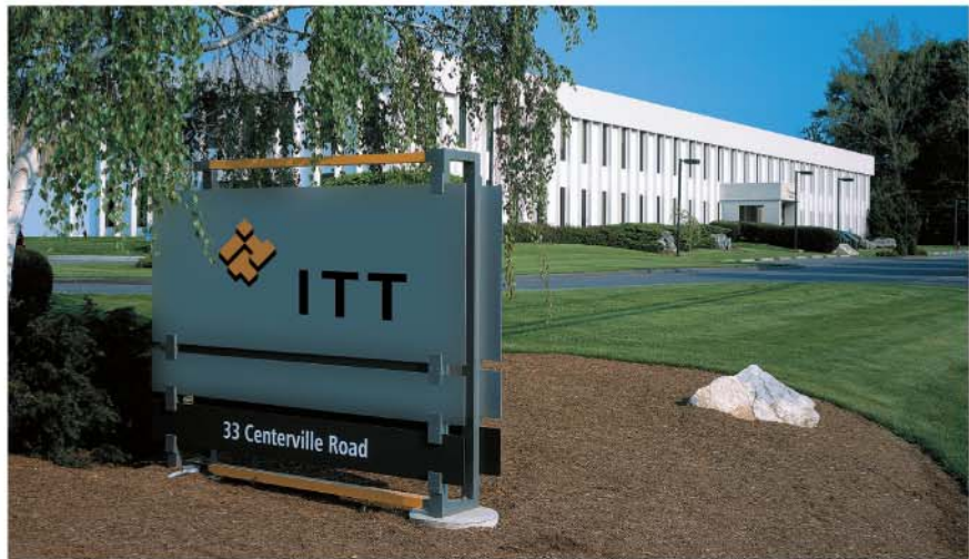
Instalaciones de Lancaster, Pennsylvania (Estados Unidos)
